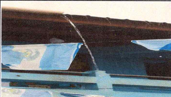
Foto 1: Sustitución de canal de pvc
