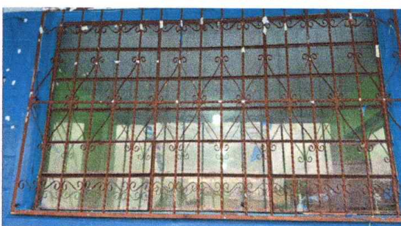
Foto 4: Sustitución de balcones de metal.
