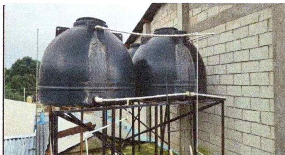
Foto 5: sustitución de depósito de agua de 2,500 lt
