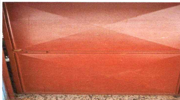
Foto 3: Sustitución de puertas
